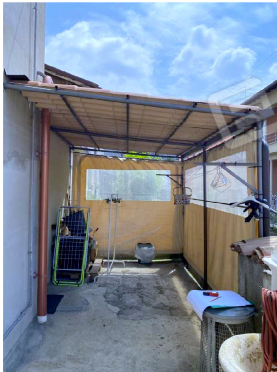
Foto 6 – Tettoia e area di sedime da corte comune
