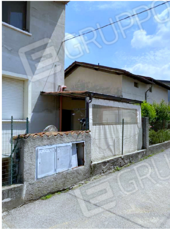
Foto 5 – Tettoia dal fronte strada
