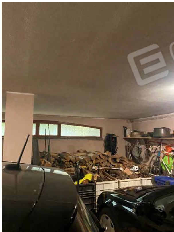
Autorimessa al piano seminterrato
