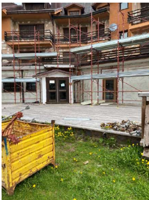
Foto 2 – Ingresso allo spazio condominiale
