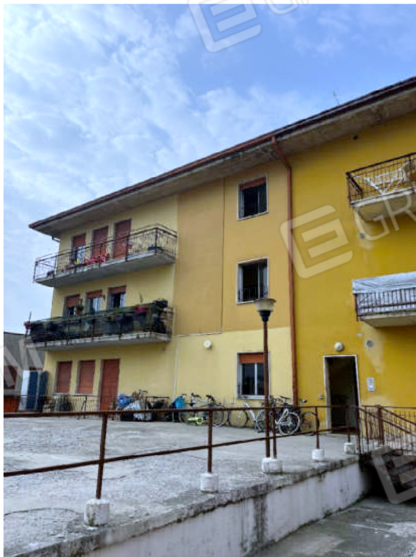
Vista del condominio
