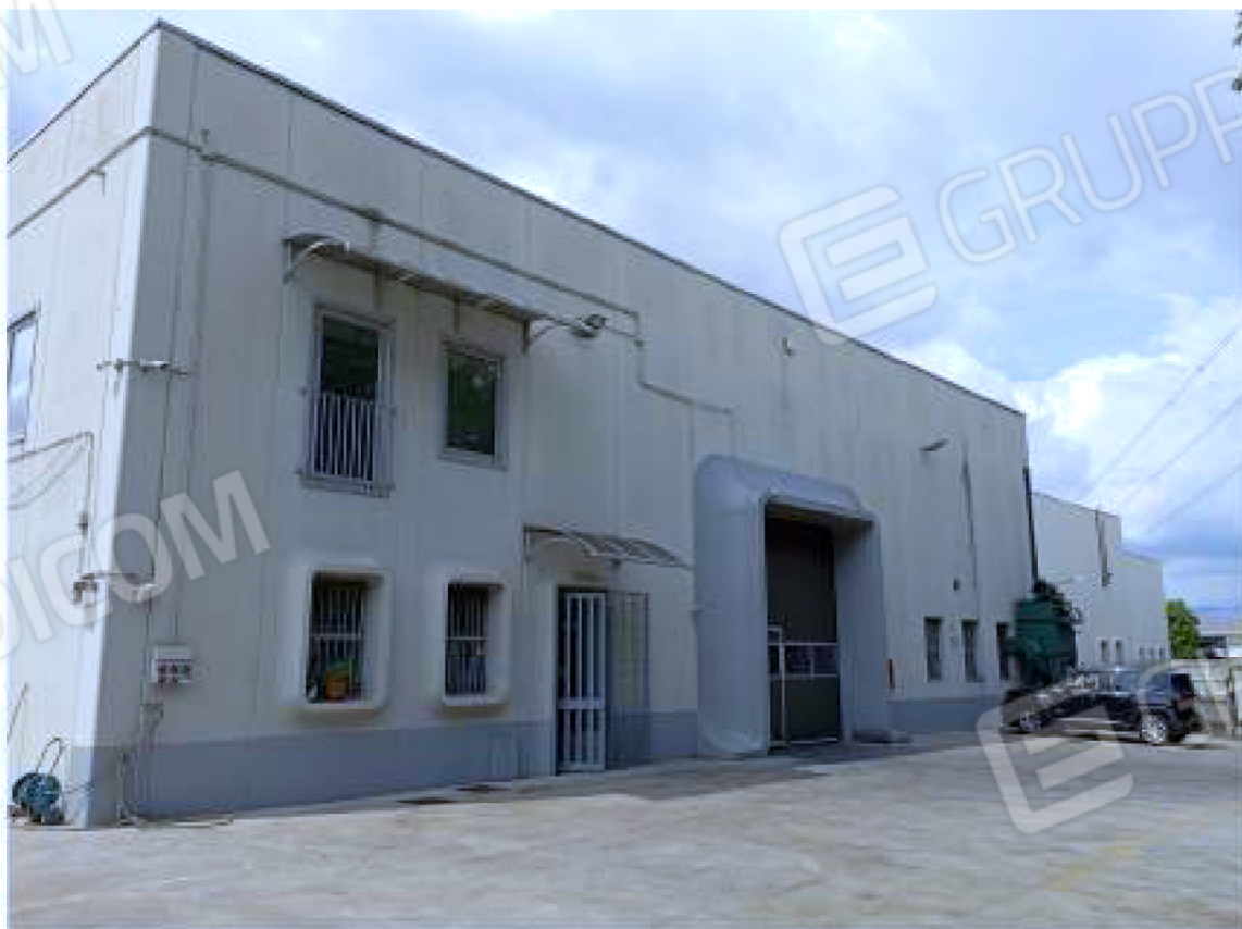
Vista esterna Viale Cristoforo Colombo n. 12 - Torbole Casaglia Prospetto Est
