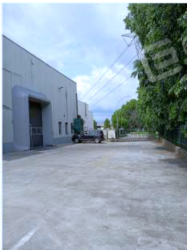
Vista esterna Viale Cristoforo Colombo n. 12 - Torbole Casaglia - Prospetto Est
