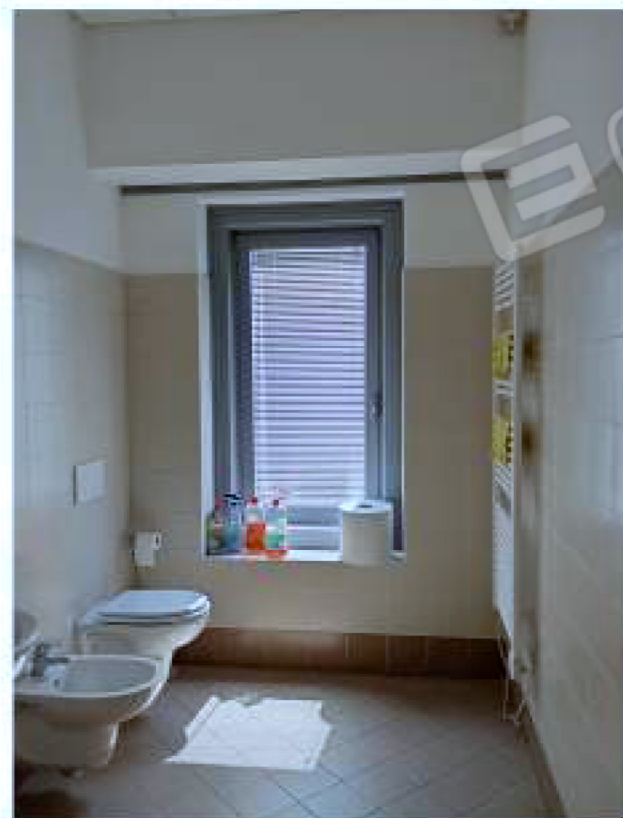
Vista interna servizi piano primo
