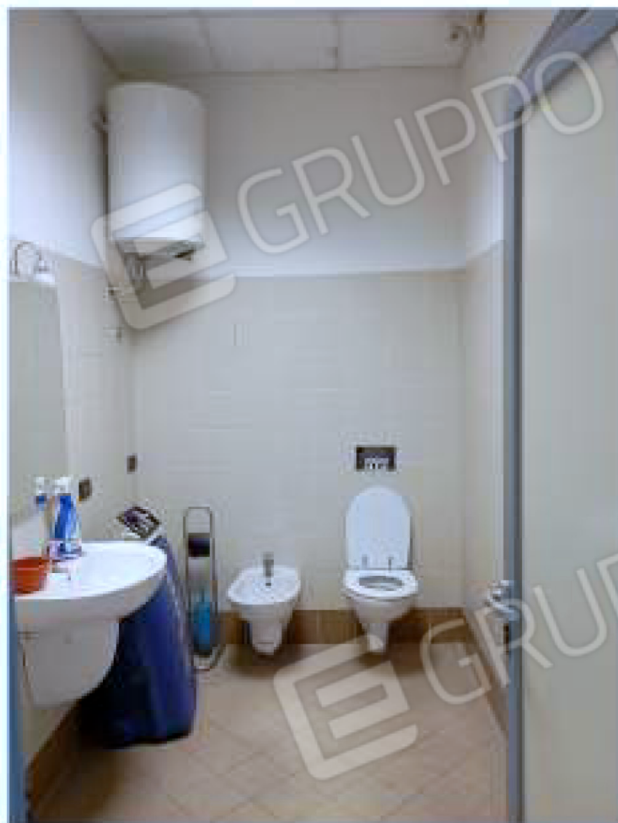
Vista interna servizi piano primo
