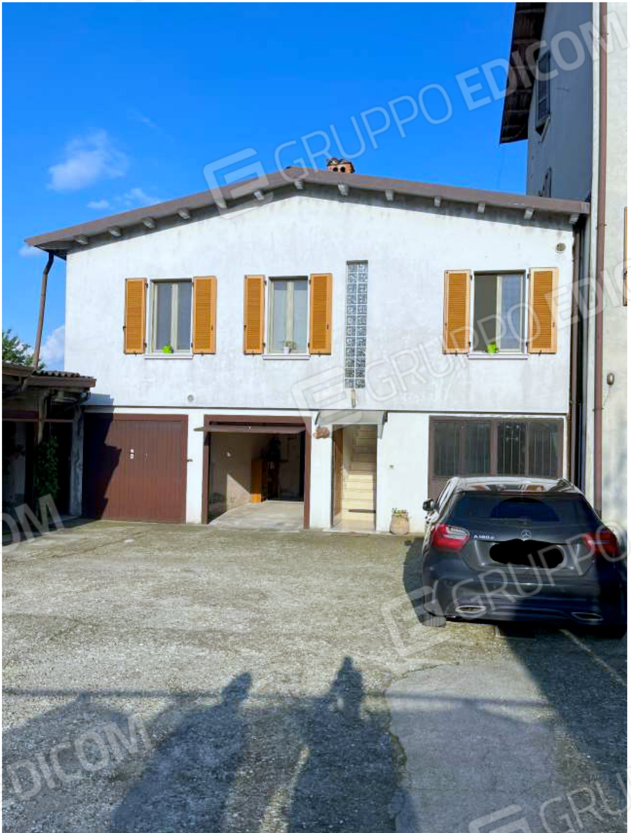
PROSPETTO OVEST DELL'IMMOBILE
