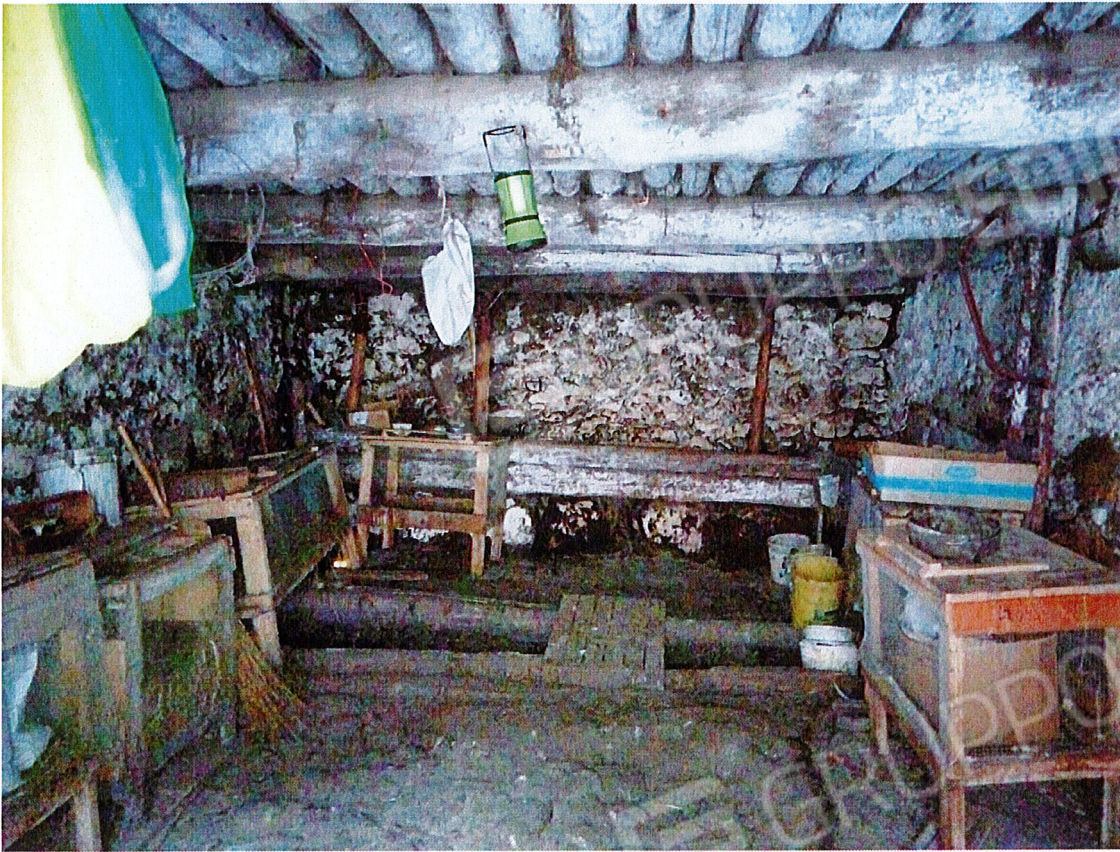
Vista interno particella n.22 sub.17
