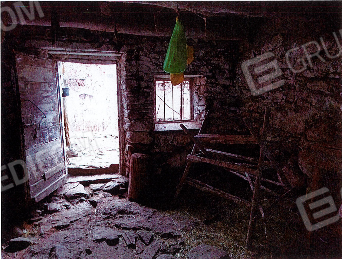
Vista interno particella n.22 sub.17
