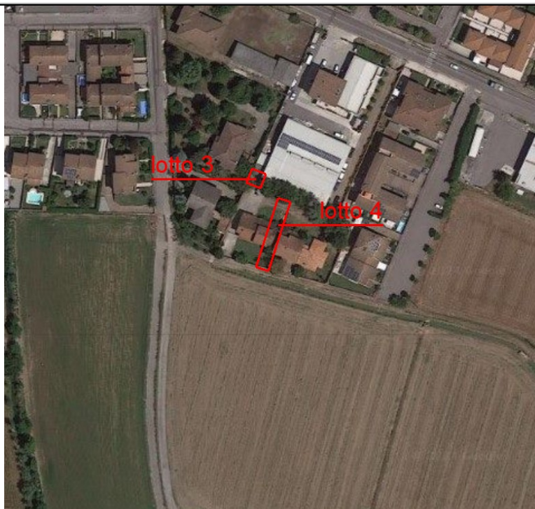
Vista Ortofoto con evidenziazione del complesso ove sono collocati i beni oggetto della presente stima
