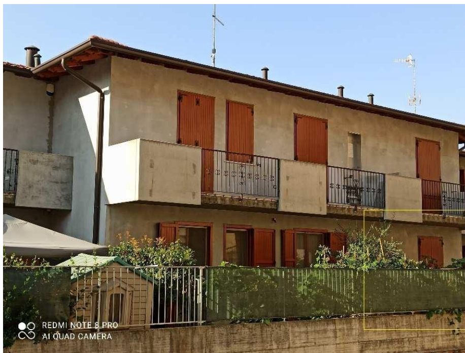
Vista esterna lato nord
