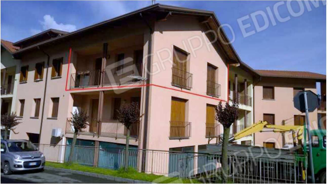
Foto n° 3 ( Facciate Sud e Est )
