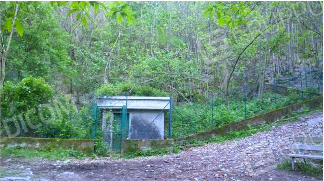
Foto n° 27 ( Arrivo – Acquedotto Comunale )
