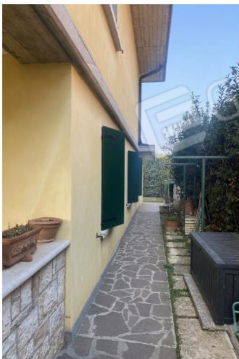
Marciapiede e area est. Comune
