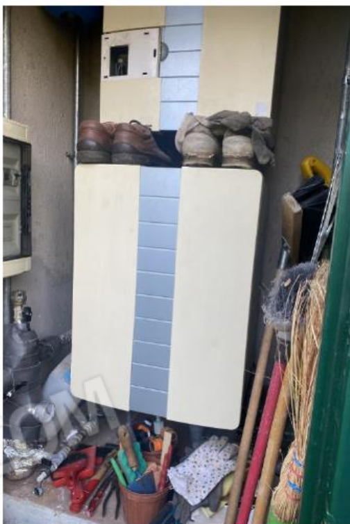
Ex Locale Caldaia
