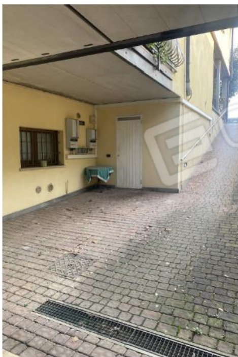
Area di Manovra
