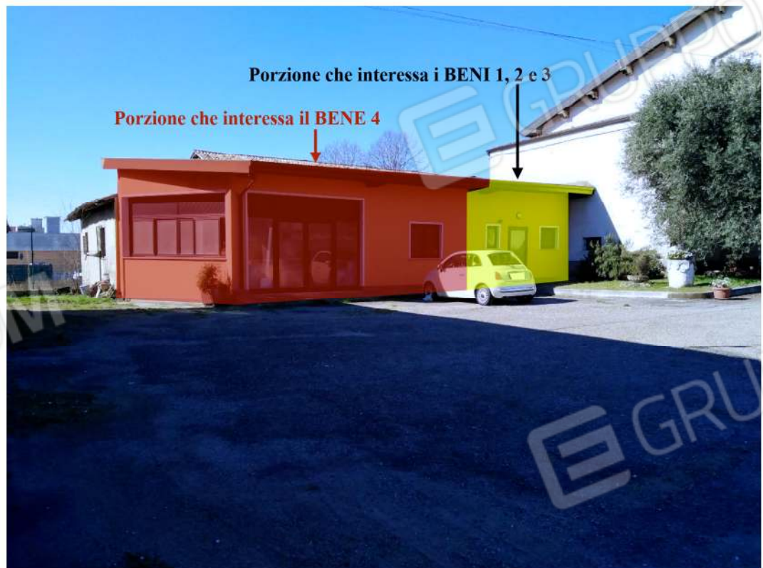
Il Fabbricato privo di titolo abilitativo di cui è prevista la demolizione
