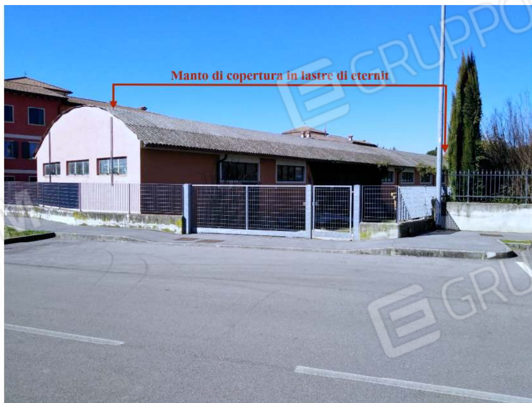
Il Fronte Sud del BENE 4 e l'accesso da Via Nassiriya snc
