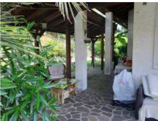
Portico in legno uso esclusivo appartamento sub 13
