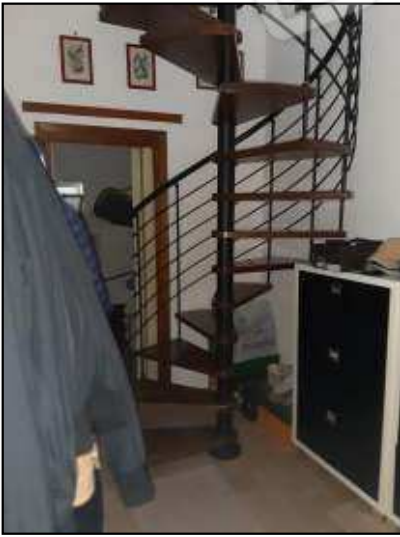
Scala di collegamento a chiocciola appartamento piano terra sub 12 con appartamento piano primo sub 13
