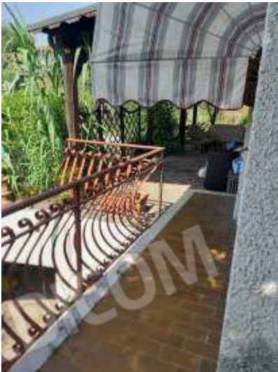
Balcone con accesso dal soggiorno
