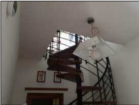
Foro nel solaio per passaggio scala a chiocciola
