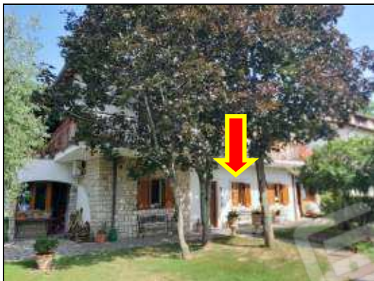
Unità immobiliare piano terra sub 12
