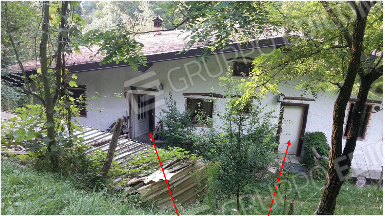
RETRO DELL'EDIFICIO CON ACCESSI ALLA ZONA RESIDENZIALE E AL B&B
