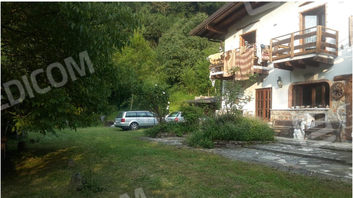
FRONTE DELL'EDIFICIO RESIDENZIALE
