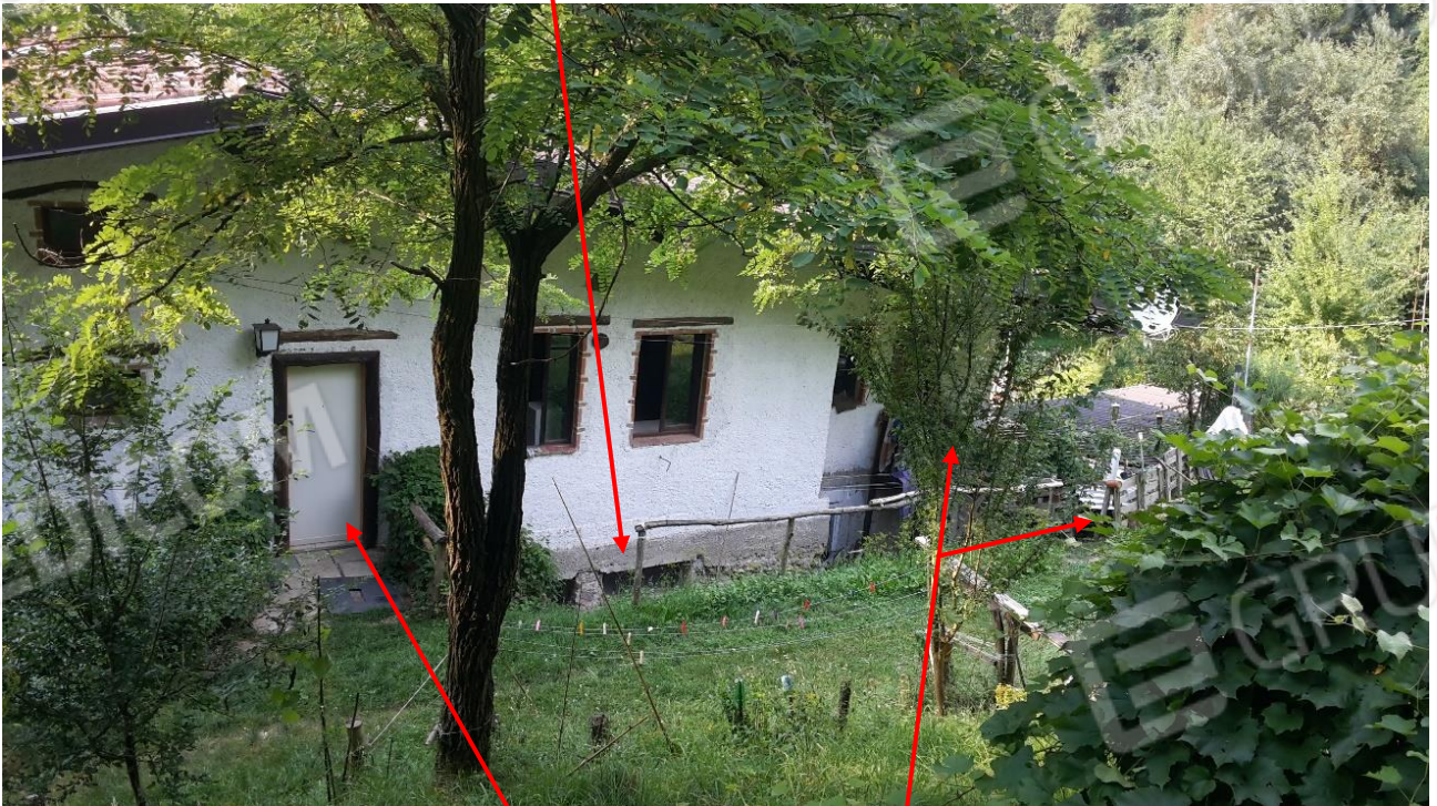
FINESTRE DELL PIANO TERRA SEMINTERRATO
