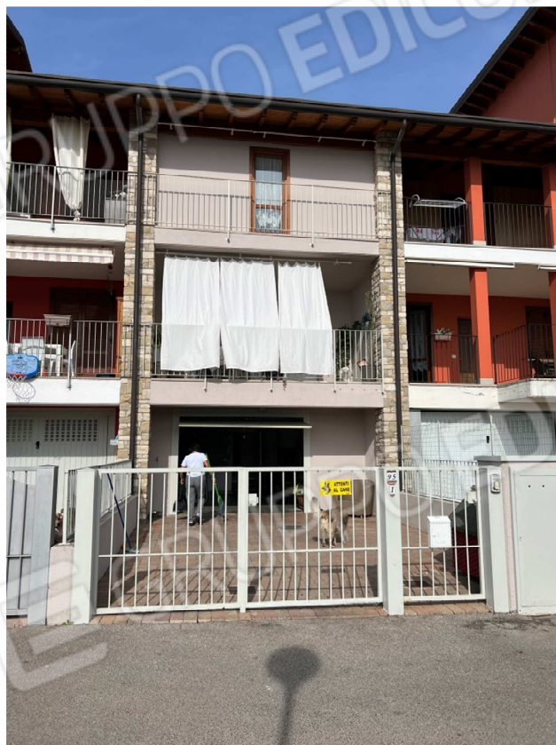
2 - Prospetto sud (ingresso immobile) -
