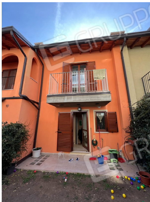
4 - Prospetto Nord dal cortiletto di proprietà
