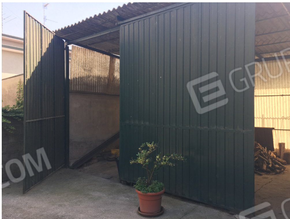
Fotografia 4 – Vista del fronte nord-ovest della porzione di manufatto da demolire
