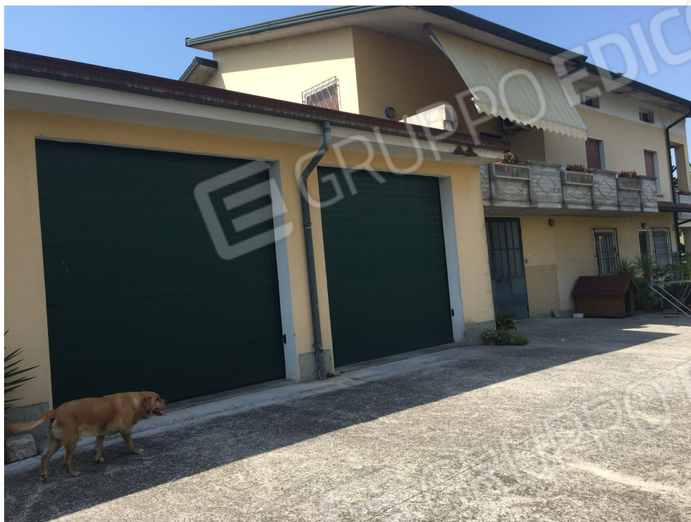
Fotografia 5 – Vista del fronte sud-est dell'edificio residenziale e della porzione di edificio adibito a laboratorio
