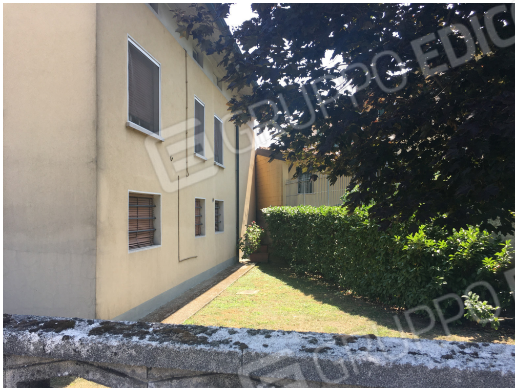
Fotografia 3 – Vista del fronte nord-ovest dell'edificio residenziale
