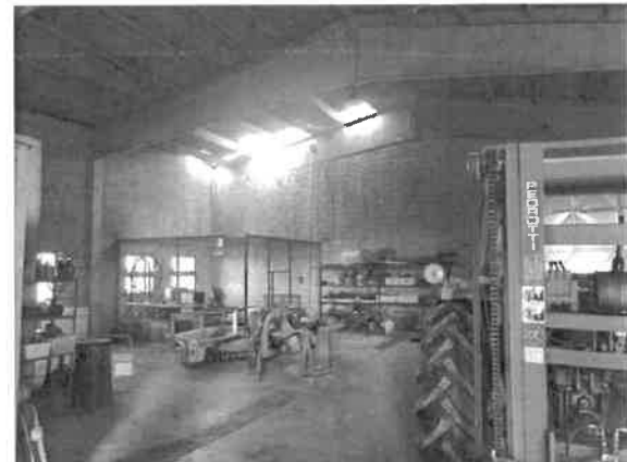
17- Copertura danneggiata del magazzino
