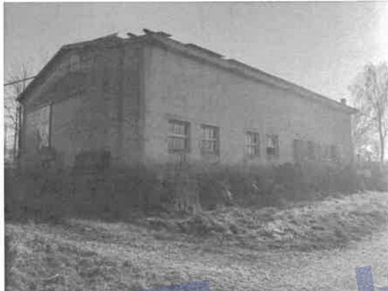
14 – Esterno del fabbricato ad uso magazzino
