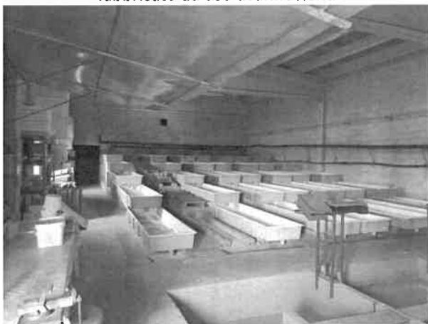
41 - interno del fabbricato ad uso avannotteria
