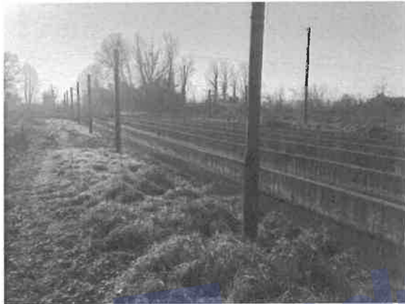
45 - vasche esterne ad uso avannotteria
