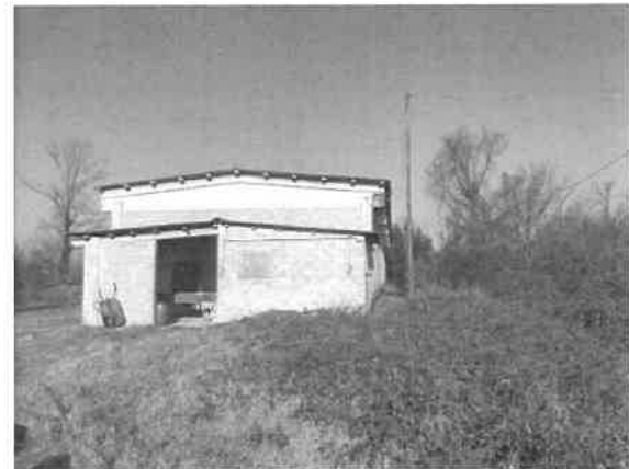
32 – Esterno del fabbricato ad uso avannotteria
