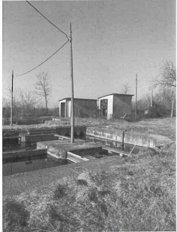
9- Manufatti per pompe
