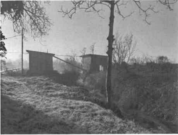
7- Manufatti per pompe
