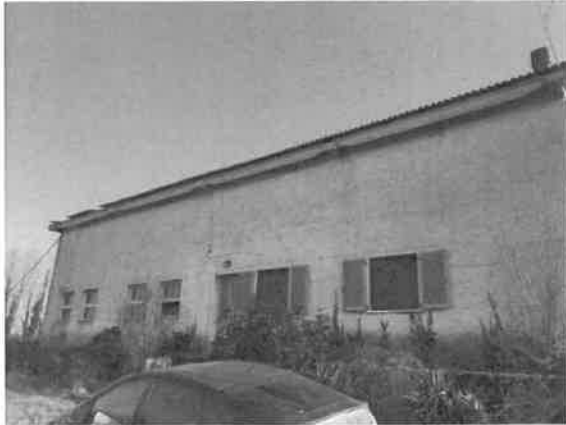
13 – Esterno del fabbricato ad uso magazzino
