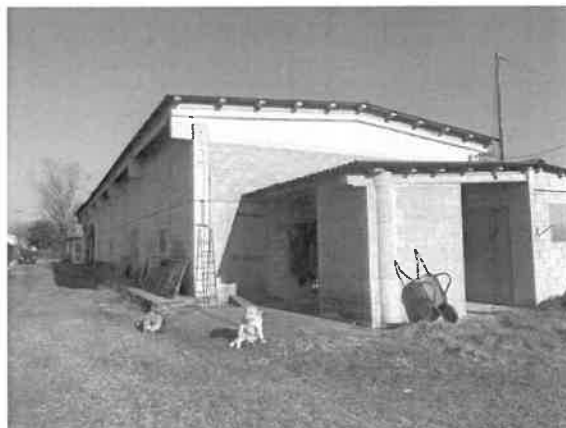
31 – Esterno del fabbricato ad uso avannotteria
