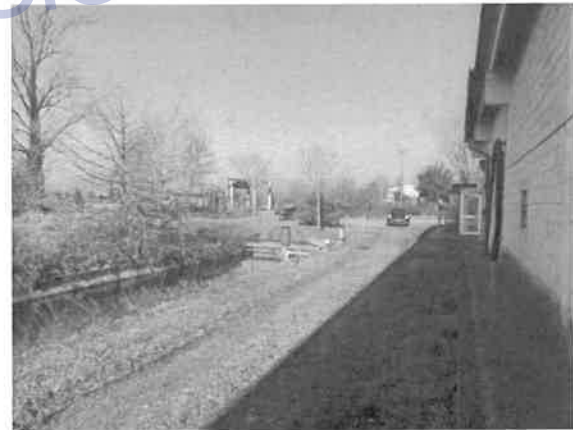
30 – Esterno del fabbricato ad uso avannotteria
