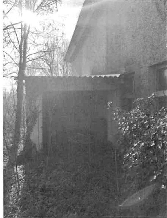
15 – Esterno del fabbricato ad uso magazzino
