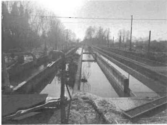
43 - vasche esterne ad uso avannotteria
