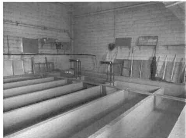
42 - interno del fabbricato ad uso avannotteria
