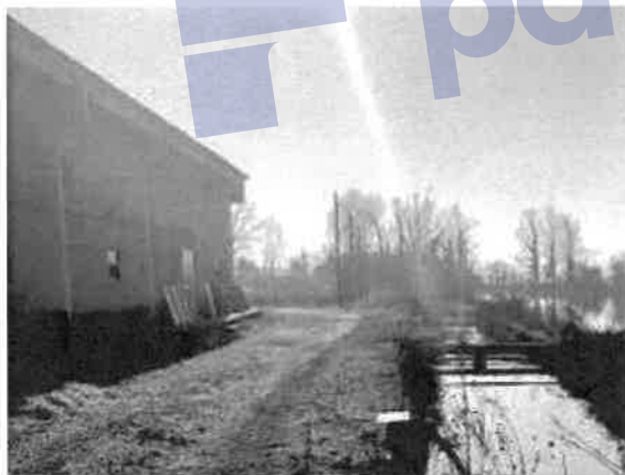
29 – Esterno del fabbricato ad uso avannotteria
