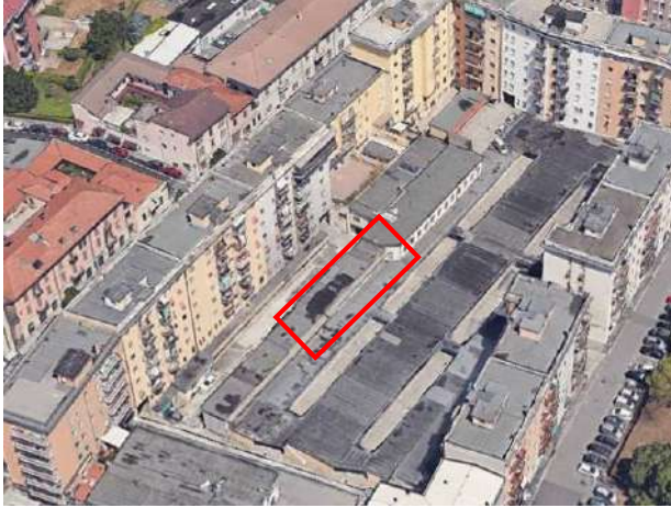
Vista aerea del fabbricato – Fonte Google Earth
