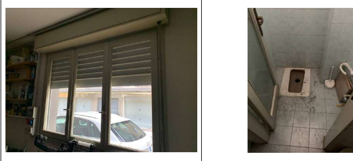
Figura 2.8: Stato manutenzione e finiture magazzino
