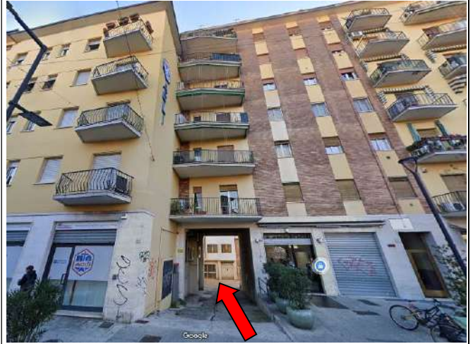
Vista dell'ingresso da via Corsica n° 169
