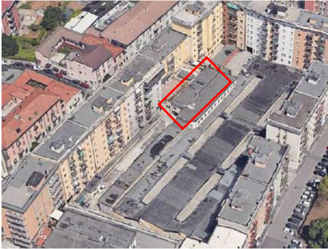
Vista aerea del fabbricato – Fonte Google Earth
