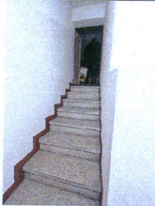
Scala verso sottotetto
