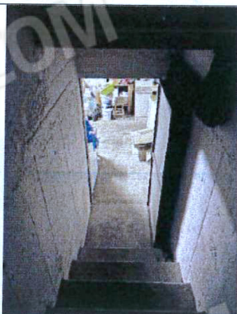
Scala verso cantina piano interrato
