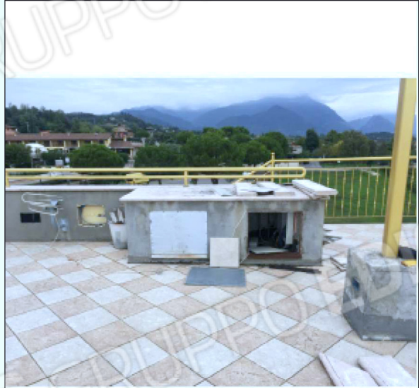
N. 96 14 - LOTTO B - Pizzeria - Particolare - impianto elettrico 1P - Sub. 21
