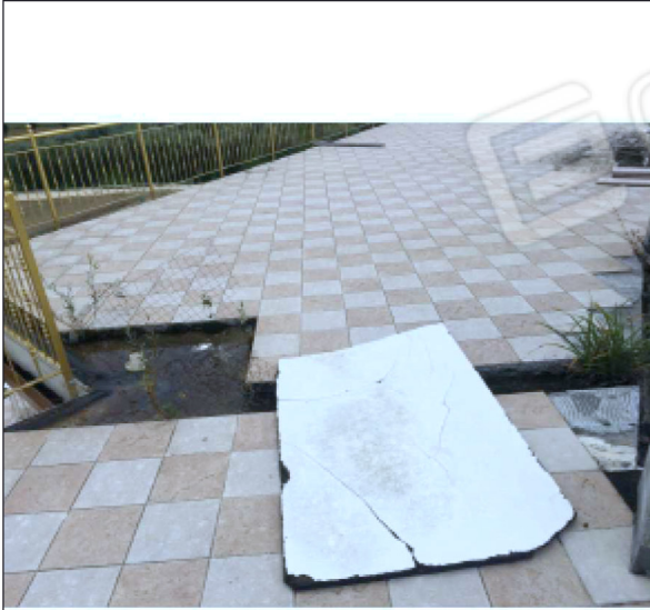
N. 95 13 - LOTTO B - Pizzeria - Particolare n.2 - pavimentazione 1P - Sub. 21
