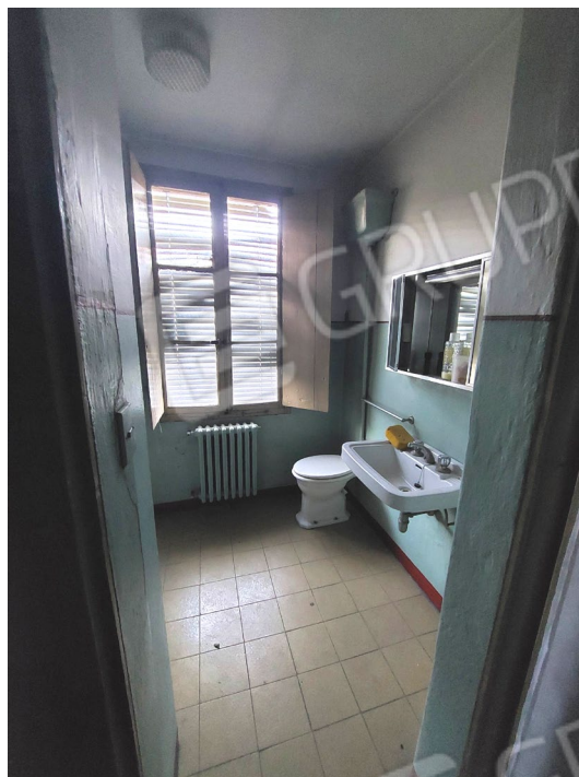
Bagno piano primo
