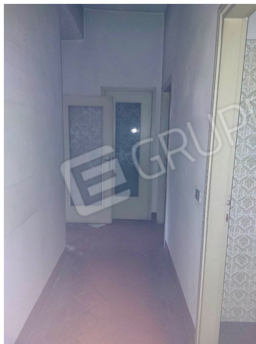
Corridoio piano primo
