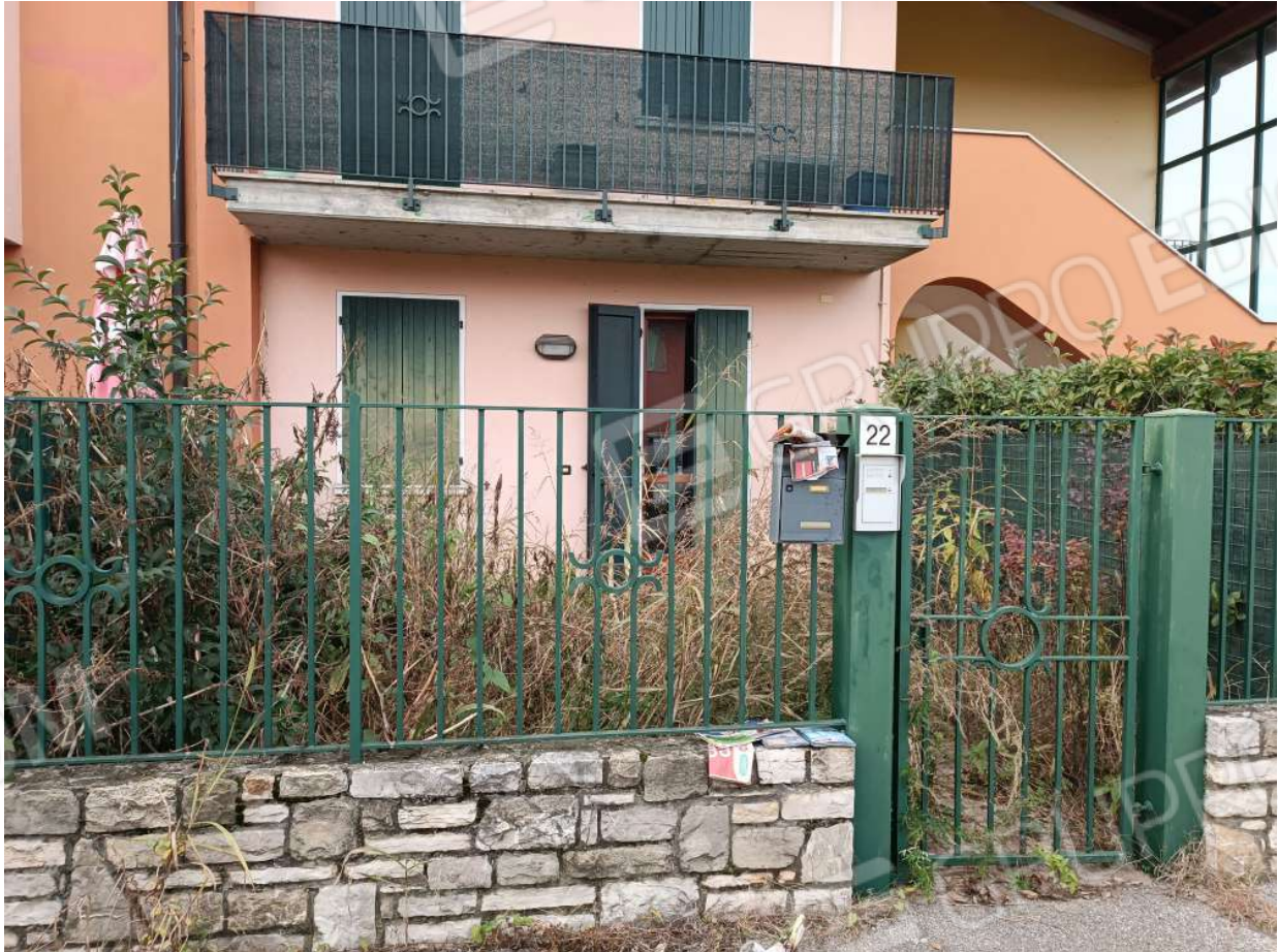
foto 1 – Vista d'insieme da strada
