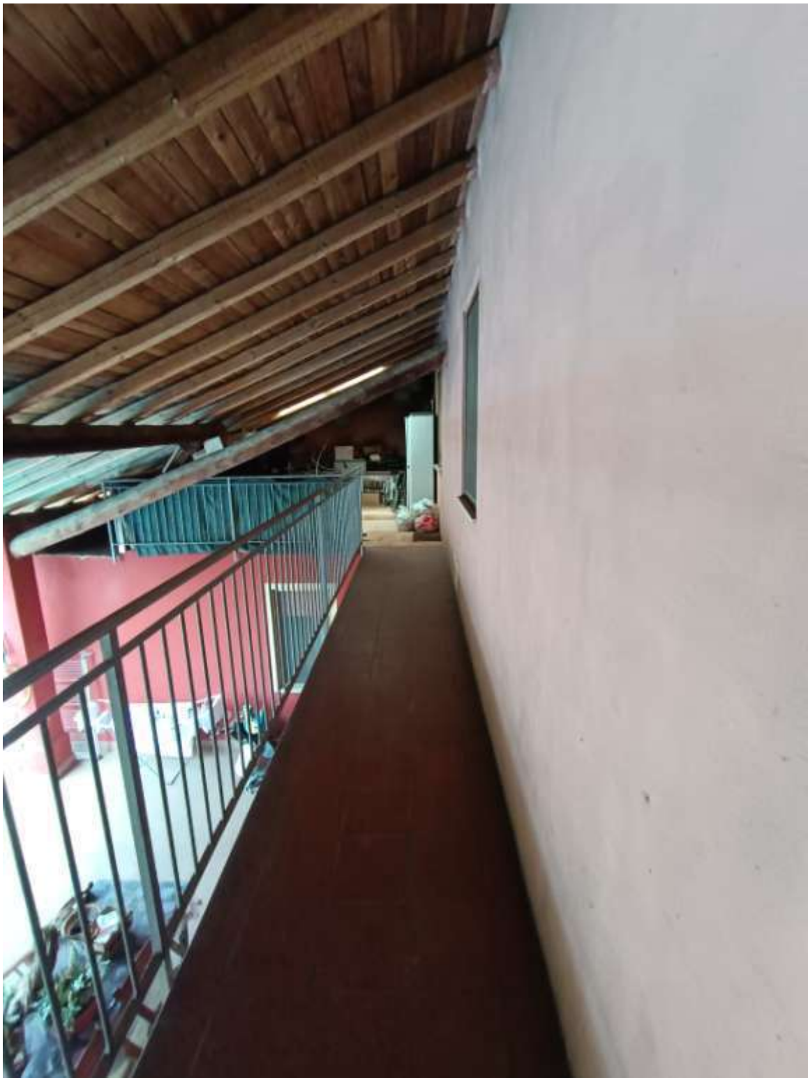
Foto 3: Particolare ballatoio fronte sud
