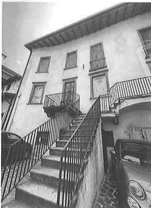
Figura 1 - Vista esterna dell'immobile
