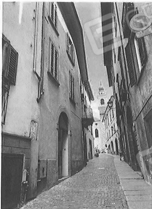
Figura 3 - Vista esterna dell'immobile
