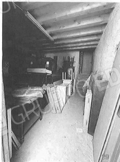
Figura 28 - Vista interna sub. 29
