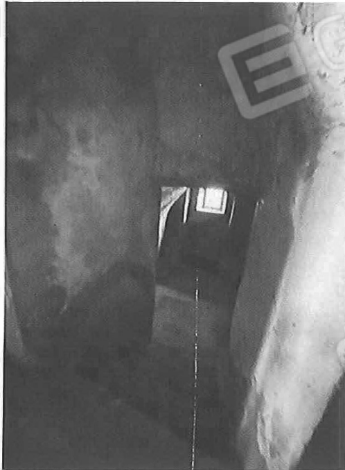
Figura 22 - Vista interna sub. 28
