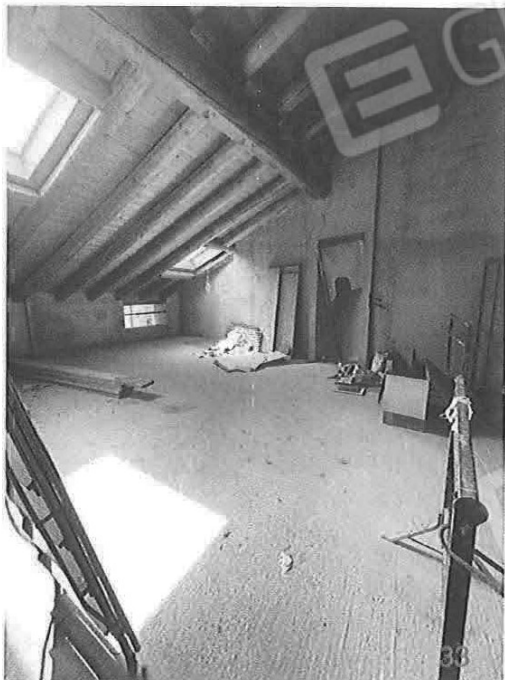
Figura 35 - Vista interna sub. 33
