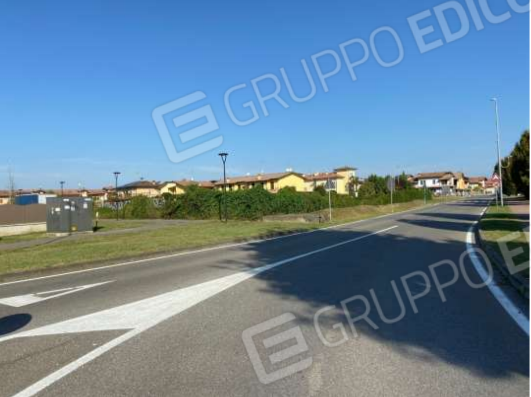
Figura 1 Vista dei lotti da via Cizzago
