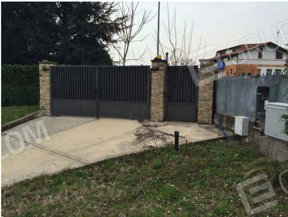
Lotto 1: vista interna dell' ingresso carraio/pedonale
