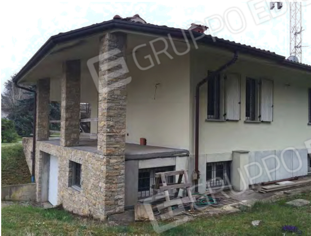
Lotto 1: vista esterna
