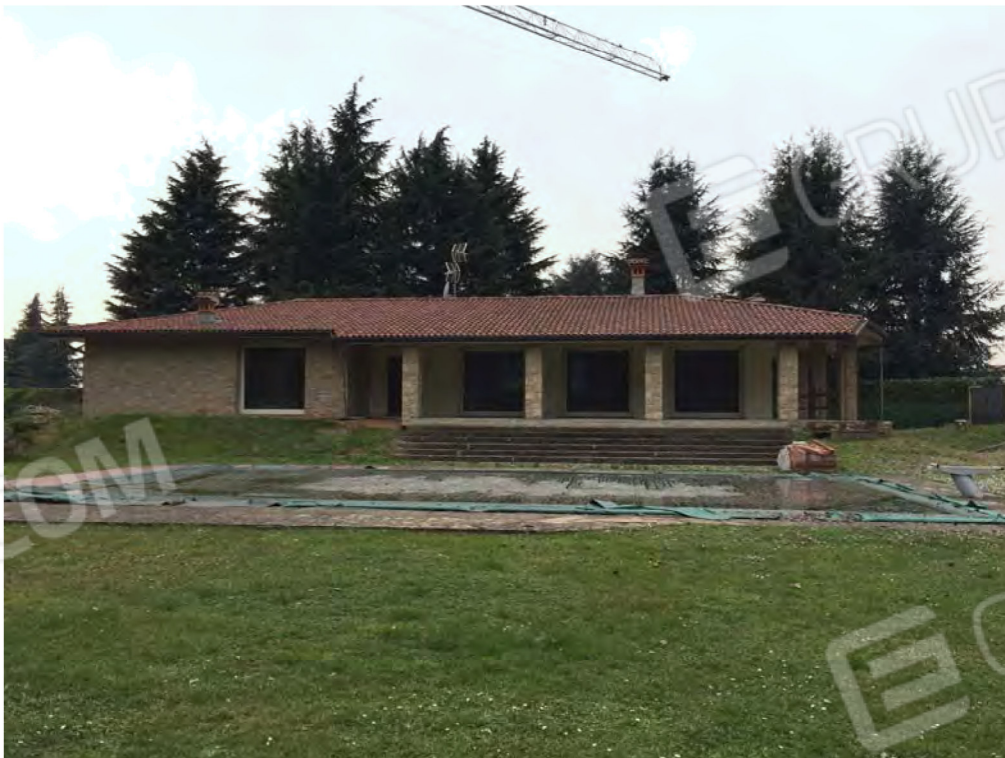
Lotto 1: vista della facciata est
