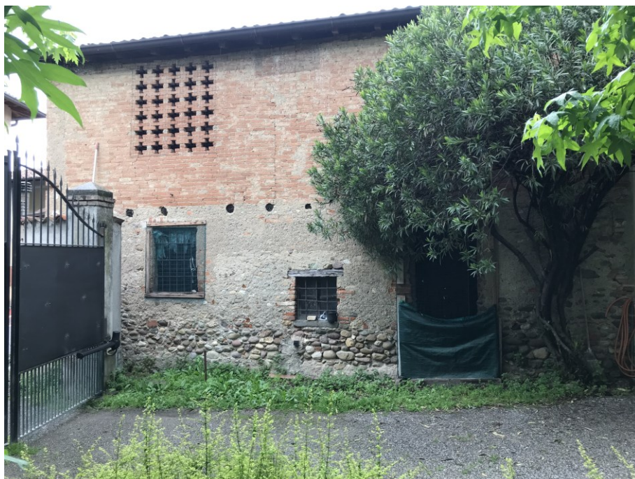
Fabbricato B – facciata e ingresso
