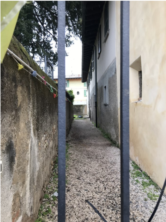
Facciata verso asilo infantile
