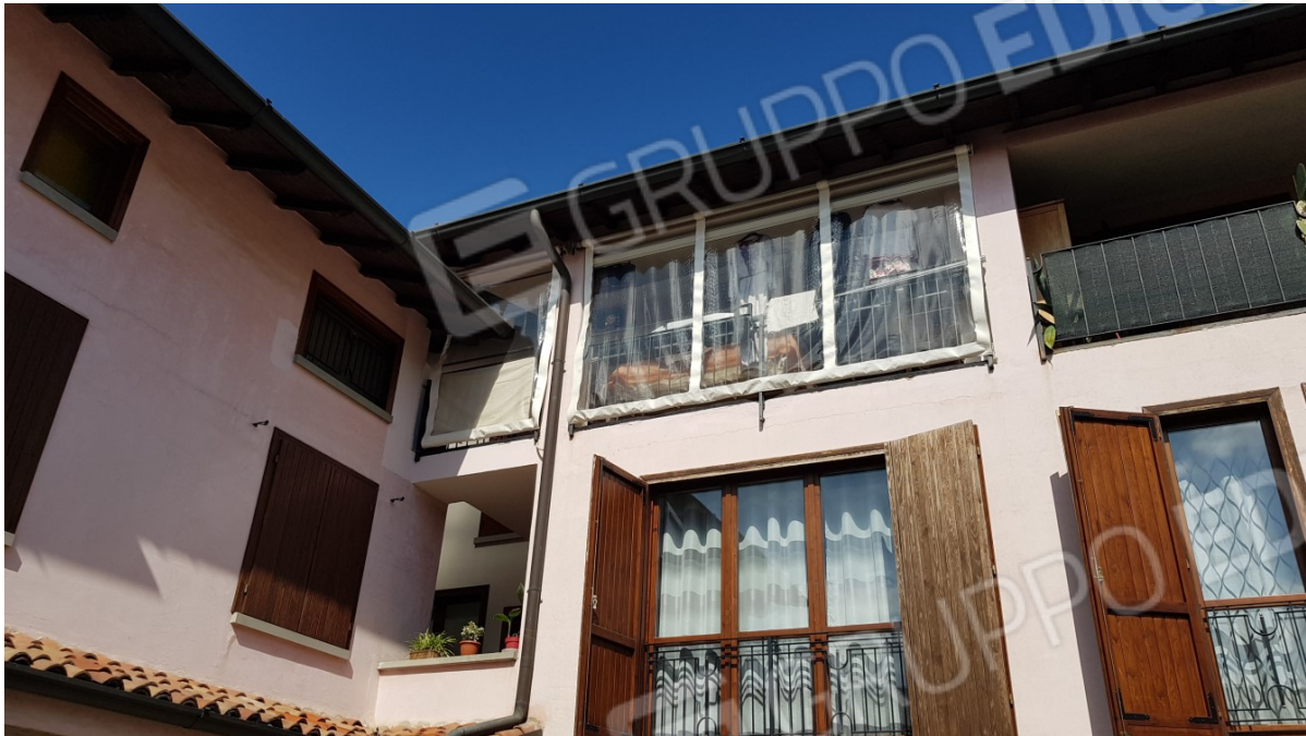
Foto n. 3 – Individuazione dell'unità abitativa dalla corte interna condominiale
