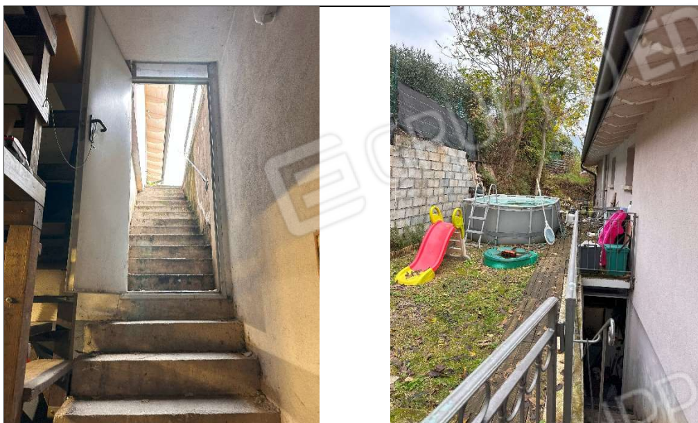
Immagine 5 e 6 : scala di collegamento piano seminterrato/autorimessa e piano rialzato abitazione – fronte ovest
