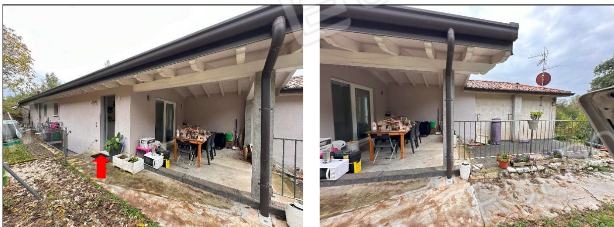
Immagine 7 e 8 : scala di collegamento piani - ingresso abitazione e portico – fronte ovest
