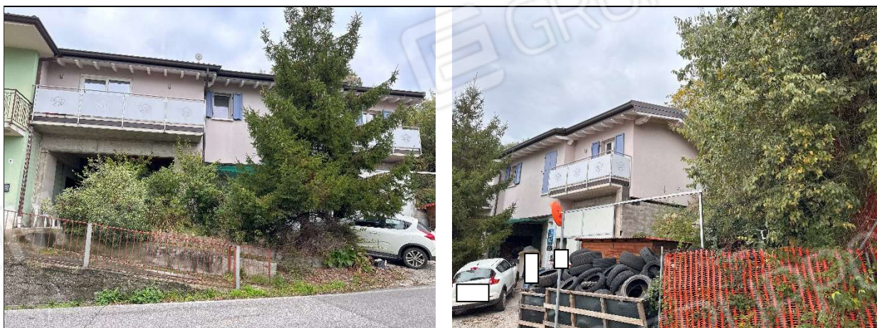
Immagini 14, 15 : prospetto est sulla via San Gallo, balcone soggiorno e finestra bagno, portafinestra camera e balcone camera matrimoniale
