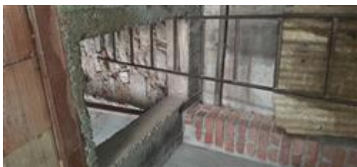
botola di accesso alla cascina del p1
