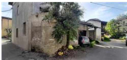
vista esterna accesso box e lato ripostiglio
