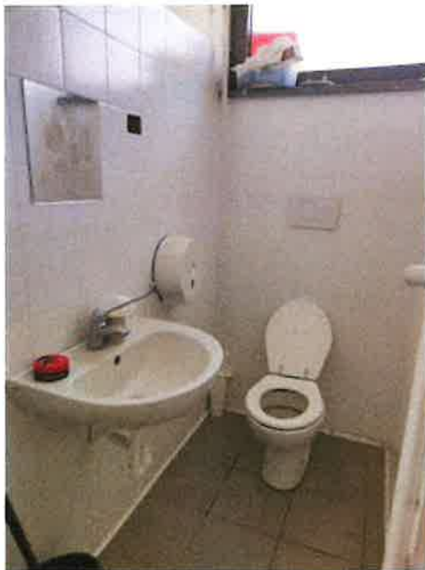
vista 5 - particolare servizio igienico
