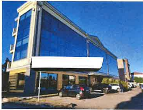
Vista prospettica 2 da area parcheggi interna
