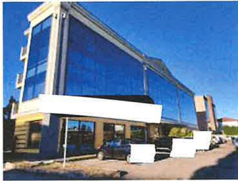
Vista prospettica 2 da area parcheggi interna
