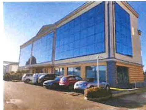
Vista prospettica 1 da area parcheggi interna
