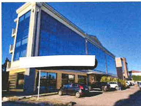
Vista prospettica 2 da area parcheggi interna
