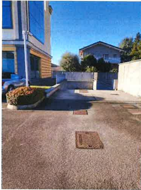
Cancello carraio comune d'accesso alla rampa
