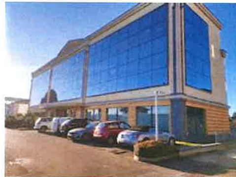
Vista prospettica 1 da area parcheggi interna
