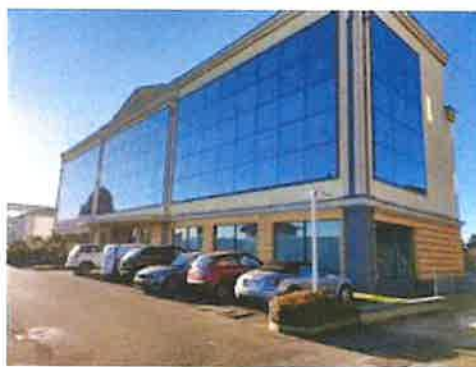
Vista prospettica 1 da area parcheggi interna
