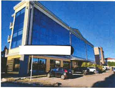
Vista prospettica 2 da area parcheggi interna
