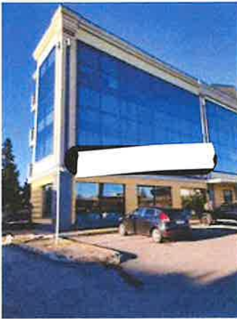
Vista porzione unità commerciale
