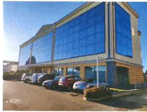
Vista prospettica 1 da area parcheggi interna
