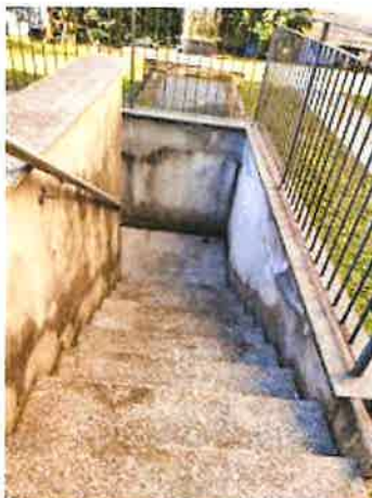
vista scala comune (per accesso pedonale al piano interrato)
