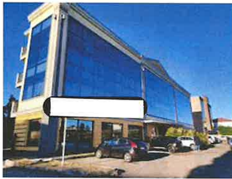
Vista prospettica 2 da area parcheggi interna
