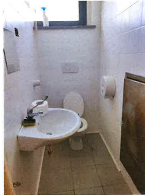
vista 6 - particolare servizio igienico
