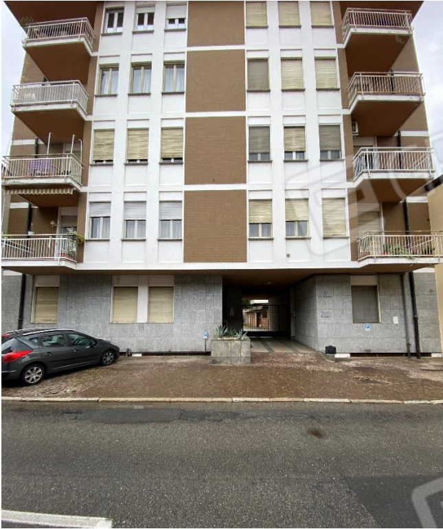
01 – Esterno facciata verso ingresso su via Volta 40
