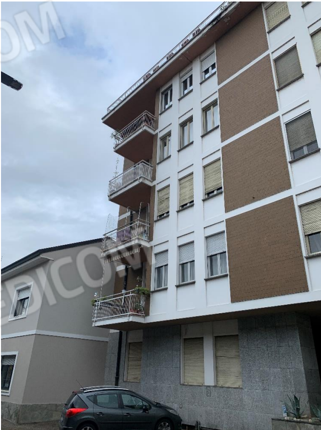
02 – Esterno facciata verso ingresso su via Volta 40
