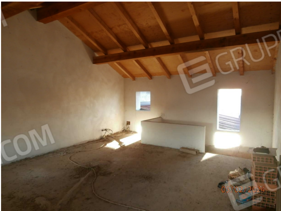
Vista interna a piano sottotetto
