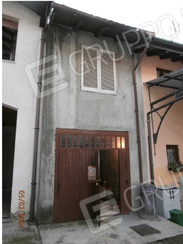
Vista esterna autorimessa e rustico da cortile comune
