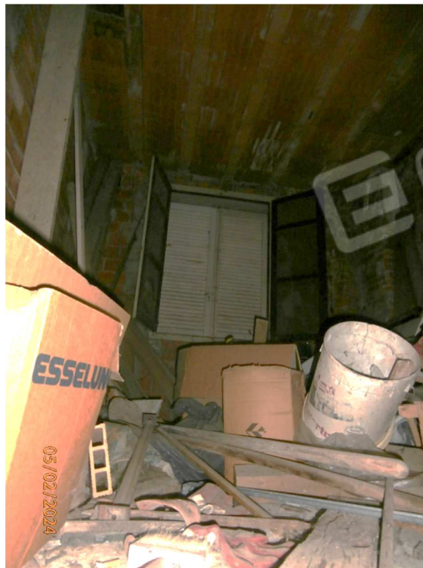
Vista interna rustico piano primo
