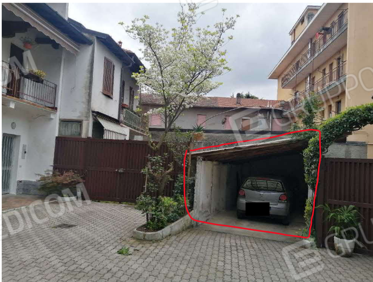
viste da corte interna
