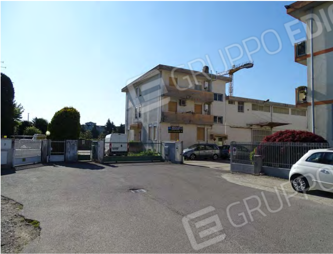
VISTA DA VIA RANCHET INGRESSO IMMOBILE
