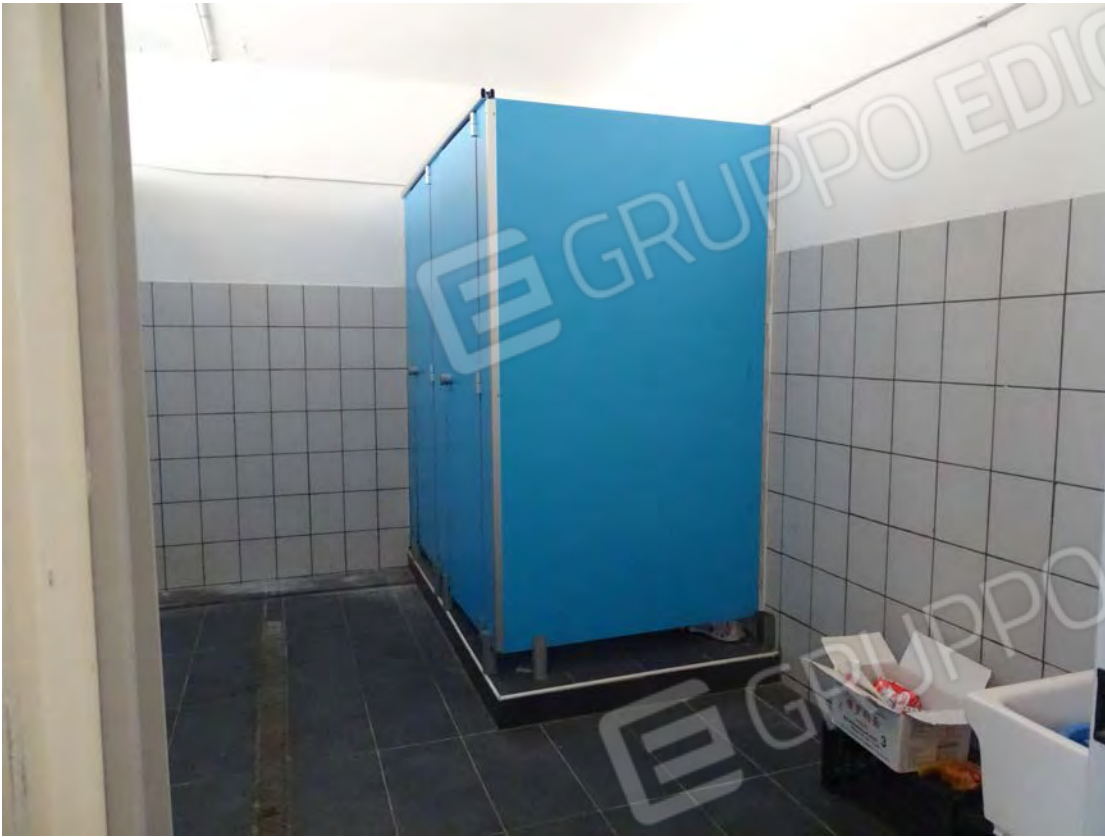
VISTA BAGNI PIANO PRIMO
