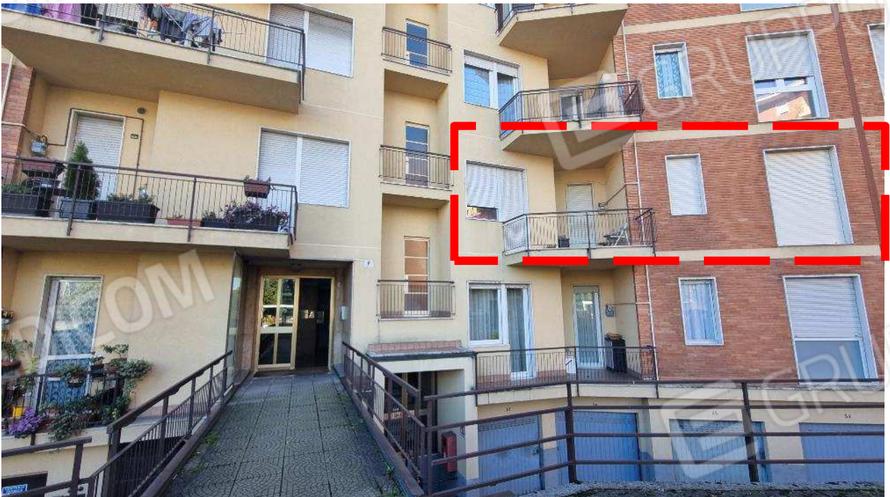
INGRESSO CONDOMINIALE E IDENTIFICAZIONE DELL'APPARTAMENTO
