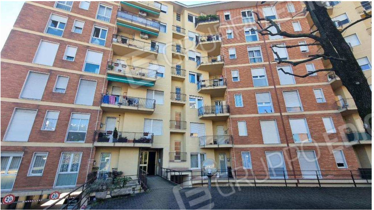
FACCIATA SU CORTILE CONDOMINIALE
