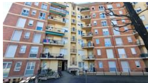
prospetto edificio su cortile condominiale
