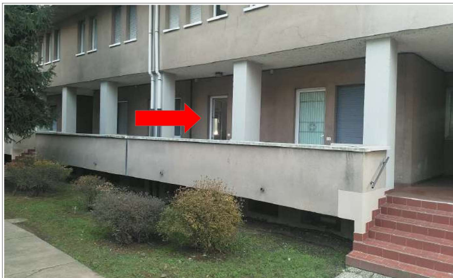
Foto dell'accesso (freccia rossa) dal porticato comune
