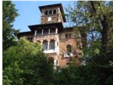
Epoca di costruzione fine 800 in stile neomedievale
