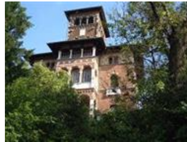
Epoca di costruzione fine 800 in stile neomedievale
