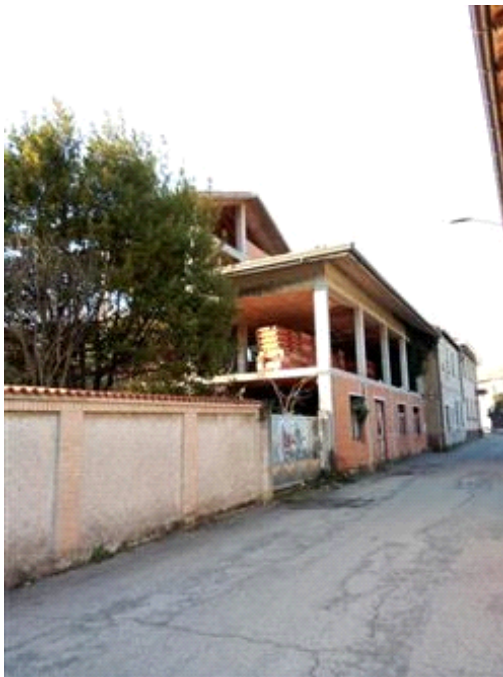
Vista Cantiere da Via Monte Grappa
