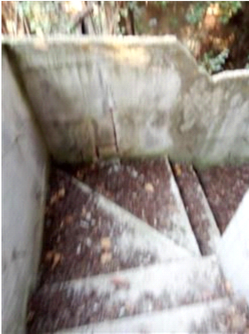
Foto scala esterna in cemento armato gettata in opera
