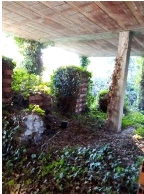
Foto interna area di cantiere
