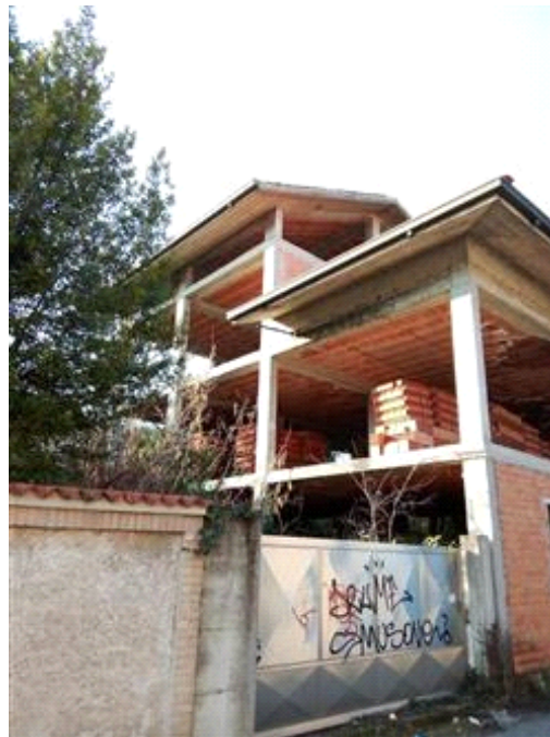
Foto corpo fabbrica al rustico vista lato Via Monte Grappa
