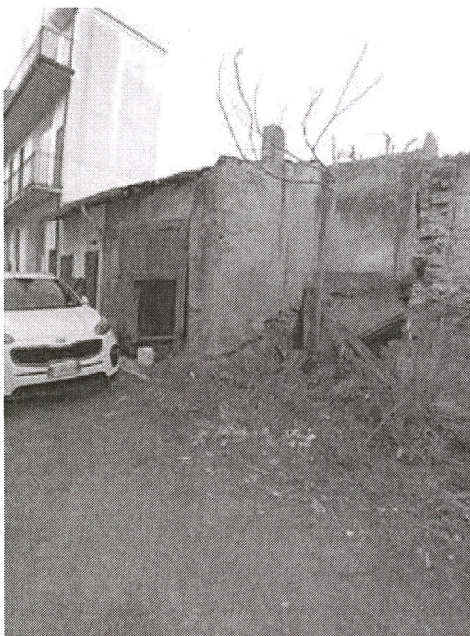
FOTO AREA CANTIERE TRA ANNESSO E PORZIONE DEMOLITA
