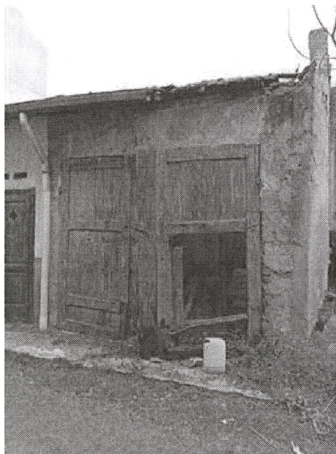
ANNESSO VISTA FRONTALE DALLA CORTE
