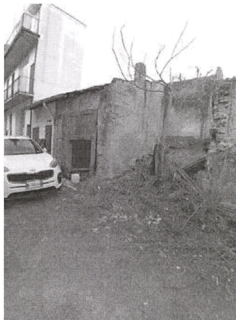
ANNESSO VISTA LATERALE DALLA CORTE
