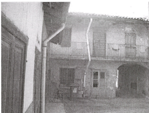
FOTO VECCHIO EDIFICIO CROLLATO E DEMOLITO A SEGUITO DEI LAVORI
