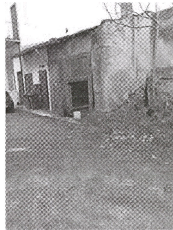
ZONA SCALA DI ACCESSO AL PRIMO PIANO DEL VECCHIO EDIFICIO ORMAI DEMOLITA E ANNESSO ANCORA ESISTENTE
