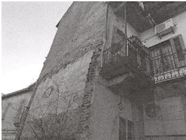
FOTO PARETE IN ADERENZA DEL VECCHIO FABBRICATO DEMOLITO LATO PASSAGGIO AL PIANO TERRA TAR LE DUE CORTI
