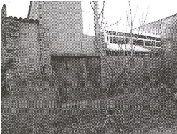
FOTO PARETI PERIMETRALI IN ADERENZA CON IL VECCHIO EDIFICIO DEMOLITO
