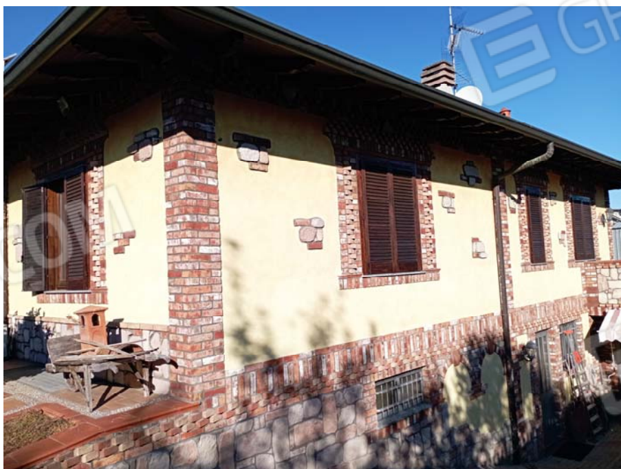
F2 FRONTE DESTRO (RAMPA CARRABILE)
