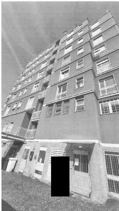
FACCIATA POSTERIORE SU CORTILE CONDOMINIALE
