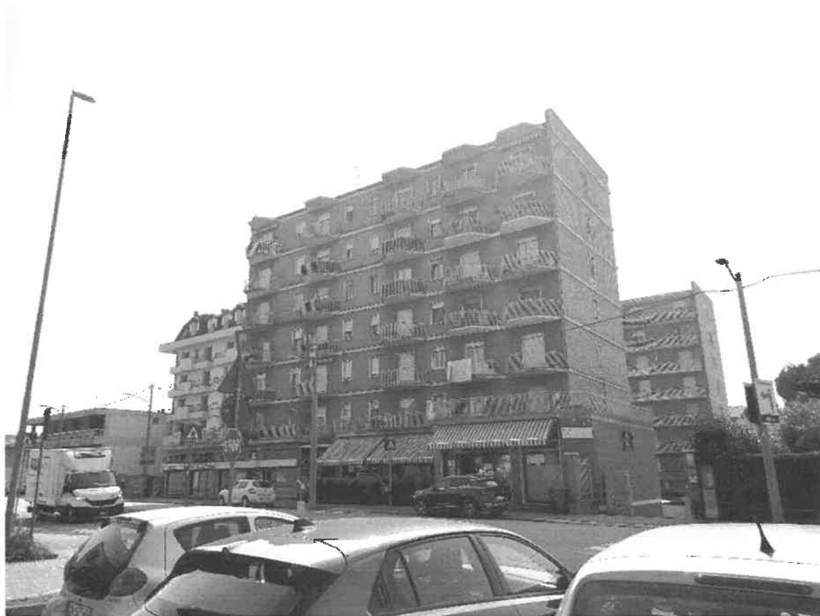
FACCIATA SU VIA BUONARROTI
