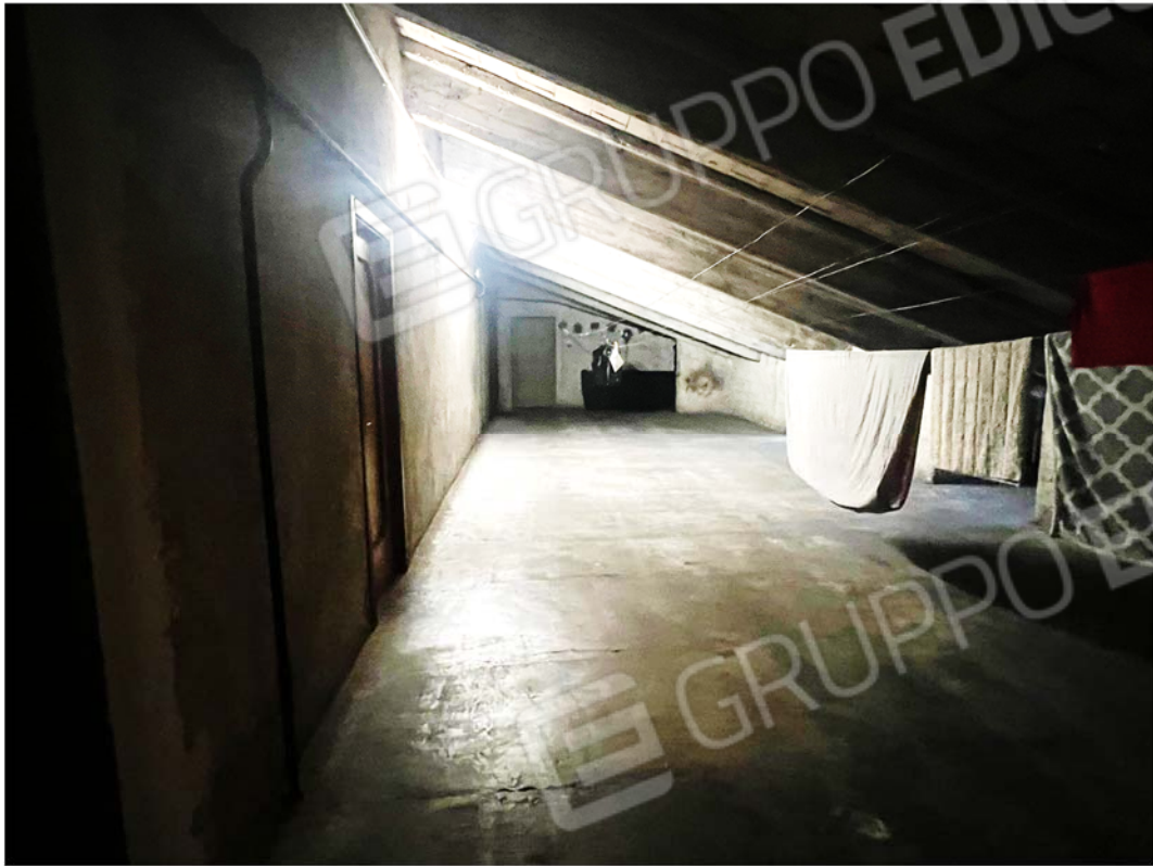
Locale comune sottotetto
