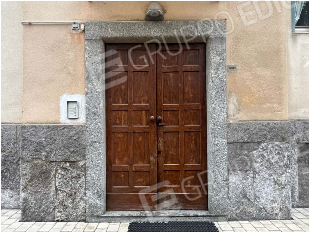
Portoncino ingresso scala A
