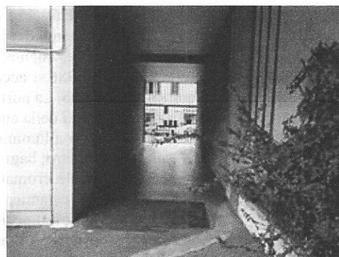
Vista ingresso carraio e pedonale dal cortile
