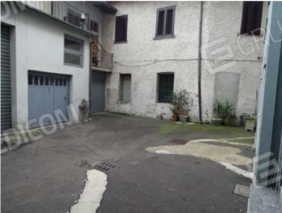
Vista cortile interno
