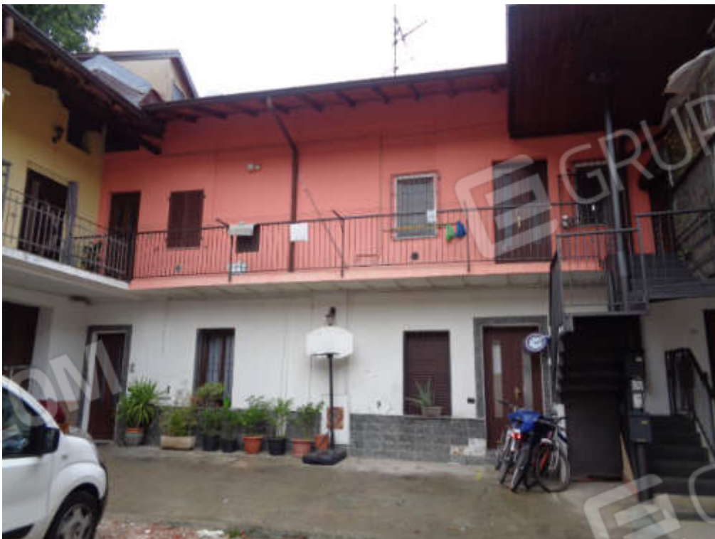
FOTO 2 Vista esterna – Fronte cortile comune
