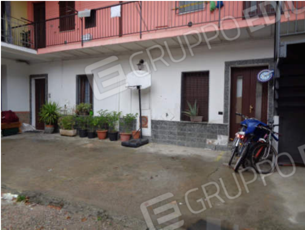
FOTO 3 Vista esterna – Fronte cortile comune
