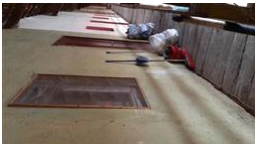
ballatoio del secondo piano
